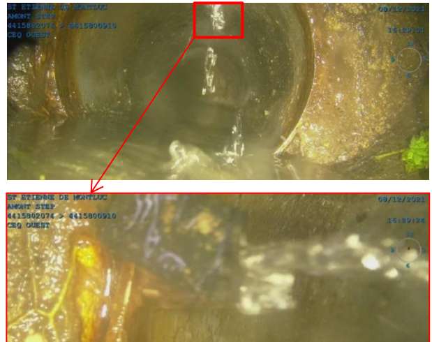
Assemblage - Infiltration par écoulement continu Amont STEP – Saint-Étienne-de-Montluc
