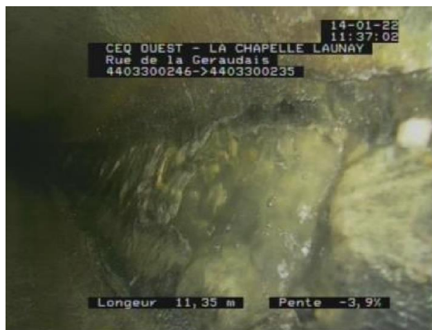
Sol visible par le défaut Rue de la Géraudais – La Chapelle-Launay
