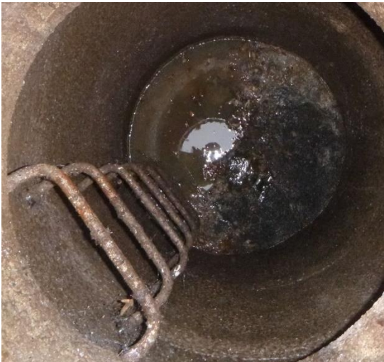
Figure 28 : Regard en charge - Savenay
