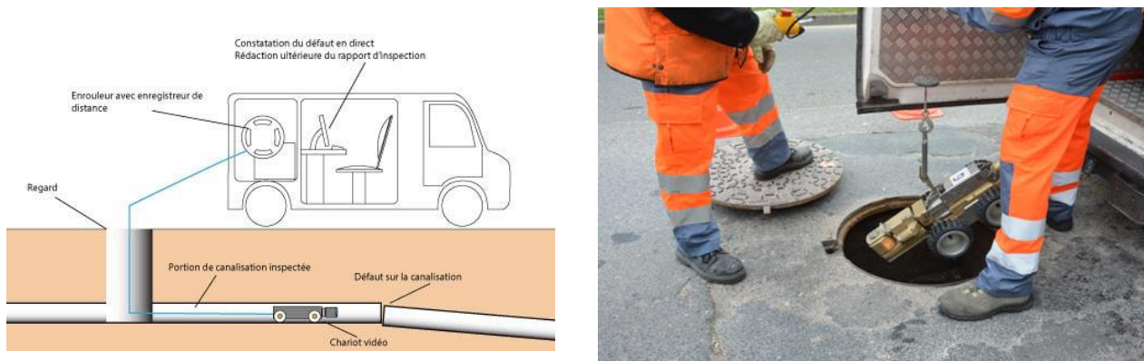
Figure 77 : Principe et matériel utilisé lors des ITV
