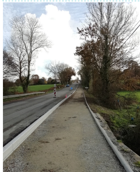
Travaux de réalisation d'une Liaison douce de Montmignac à Campbon.
