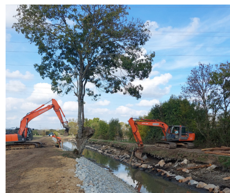
Restauration des berges de l'étier de la Chaussée Cordemais/Bouée
