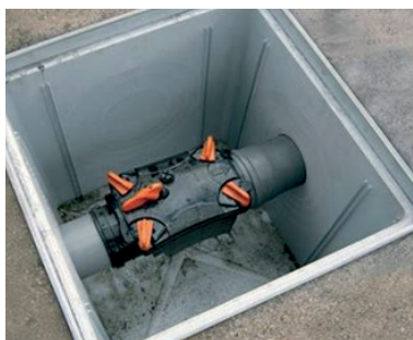
Clapet anti-retour dans un regard visitable
