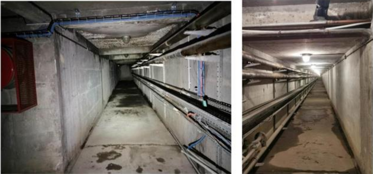
Figure 39- Couloirs du réseau souterrain
