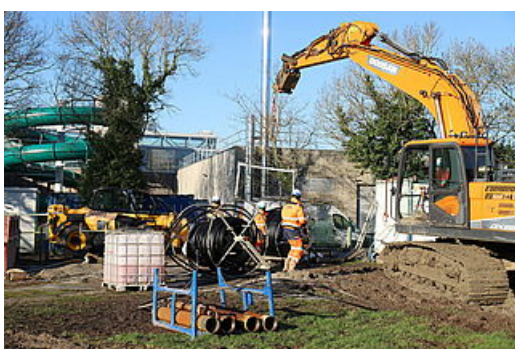
Travaux géothermie à Aquamaris à Cordemais
